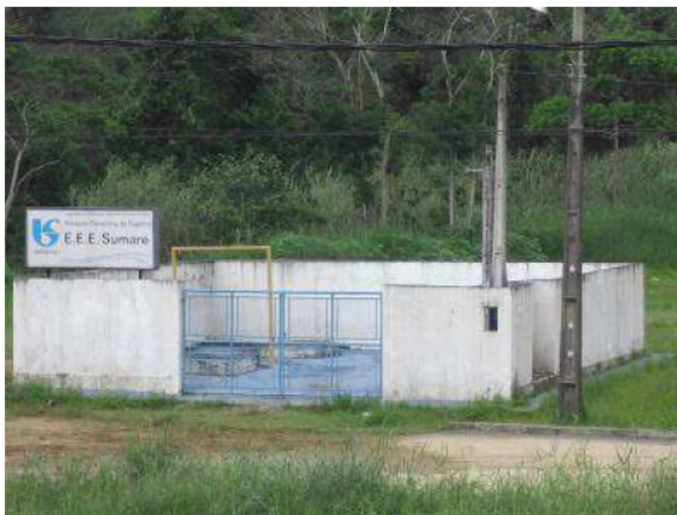
Foto 7 – EEE Sumaré – Sistema Principal
